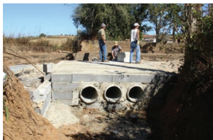
Construção das Infraestruturas da Ribeira do Seissal
