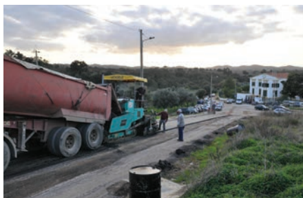
Pavimentação de Arruamentos em Colos
